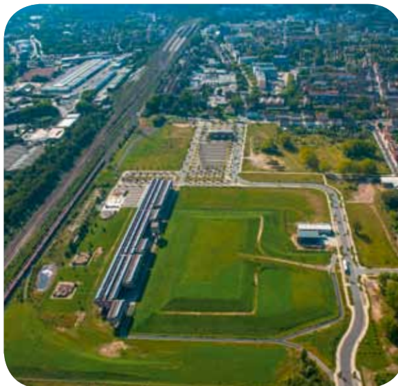
● Schalker Verein von Osten mit Solarbunker
