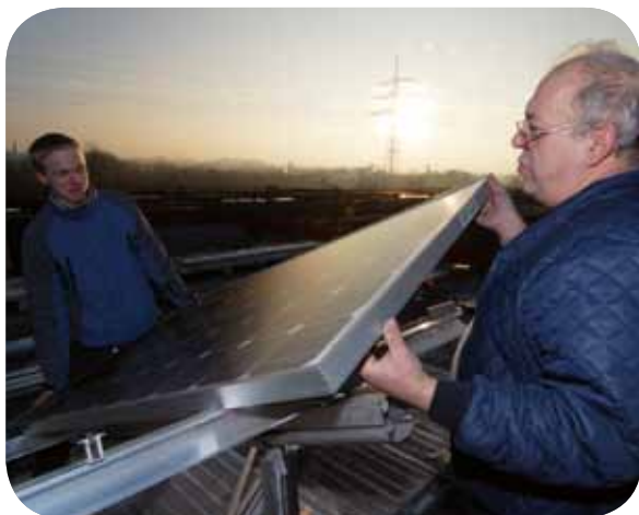
● Montage der Solarpaneele
