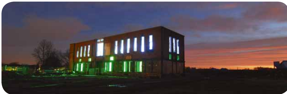
● Festbeleuchtung für das Schalthaus – Warten auf Investoren
