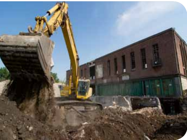
● Geländearbeiten für die Eingangsplätze
