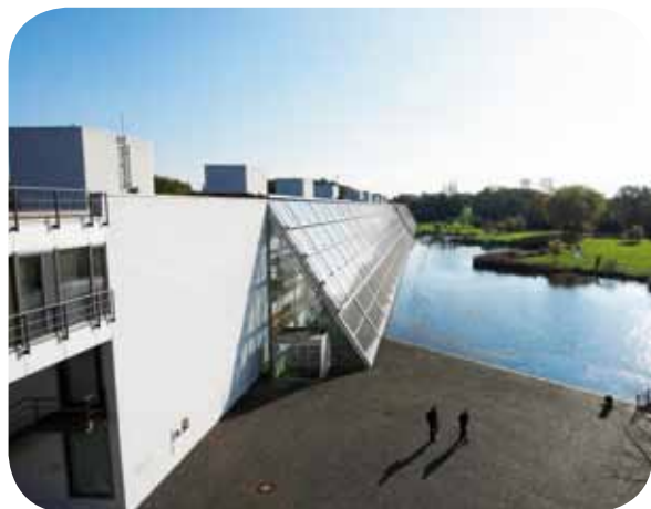
● Der Wissenschaftspark: Arbeiten am Wasser
